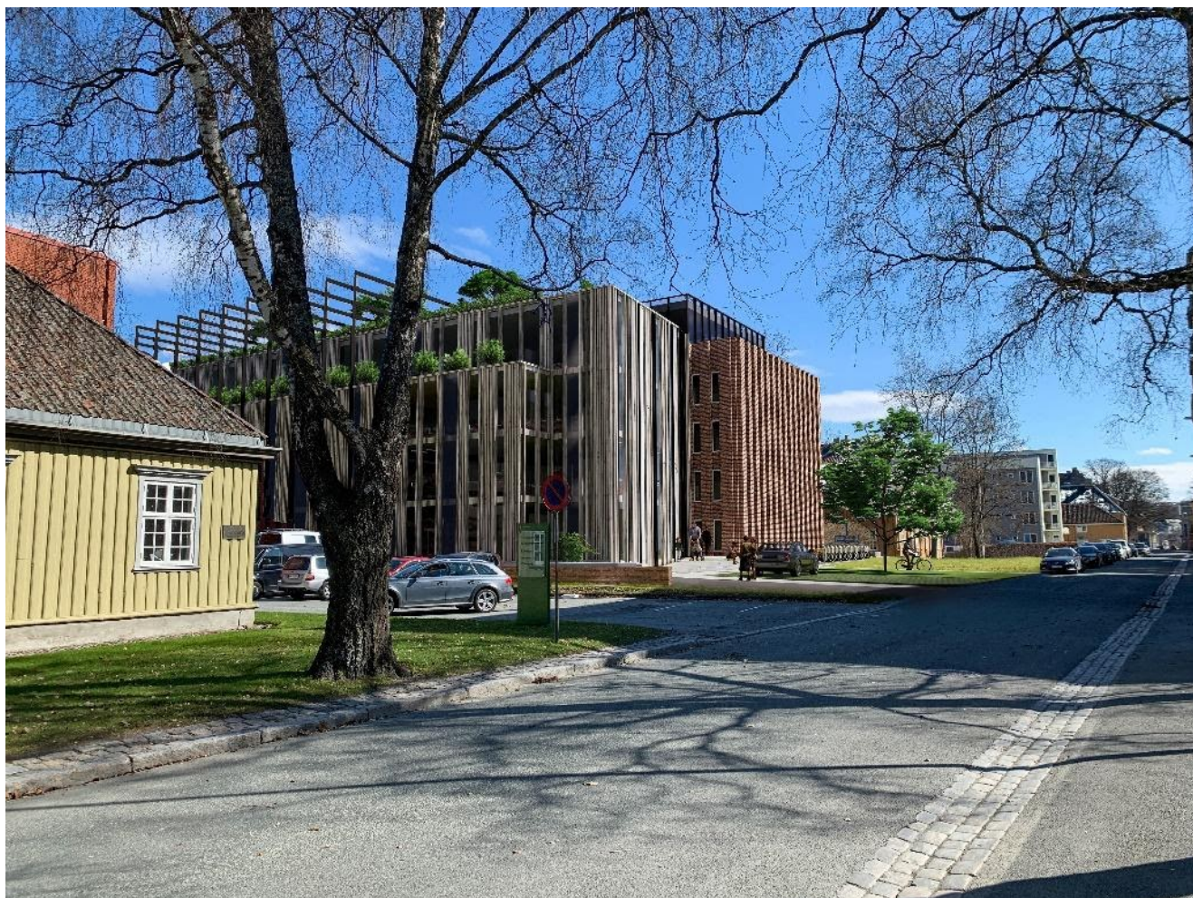
Nytt tilbygg og påbygg sett fra sørvest i Erling Skakkes gate.
