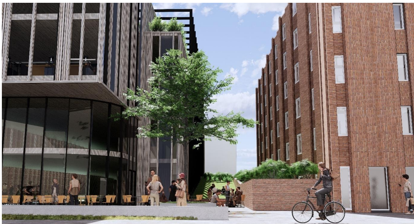
Nærvirkning nytt tilbygg sett fra nord.
