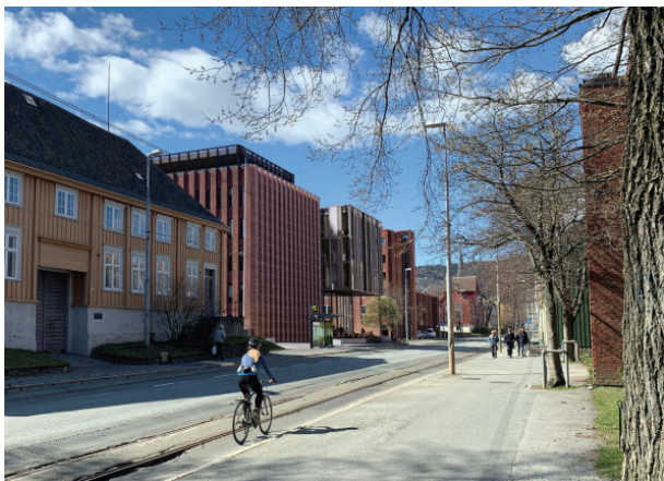
Utkraging på tilbygg sett fra gatenivå i Kongens gate mot vest.
