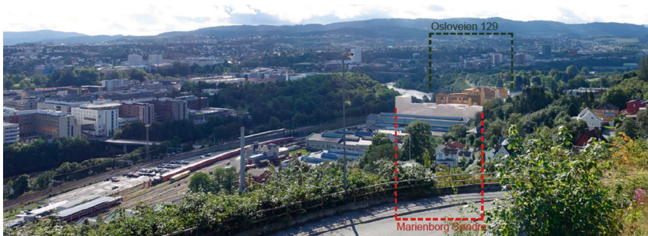
Fjernvirkning sett fra Utsikten.
