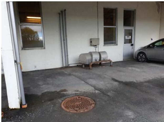
Figur 27 Bilde av påfyllingskasser og lufterør for oljetanker. Bilde er tatt under befaring 2. mai 2019.
