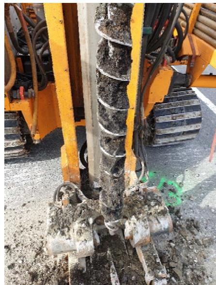
Figur 23 Prøvepunkt M13, dybde 4-5 meter, hvor det ble registrert organiske masser med innhold av kull og treflis.
