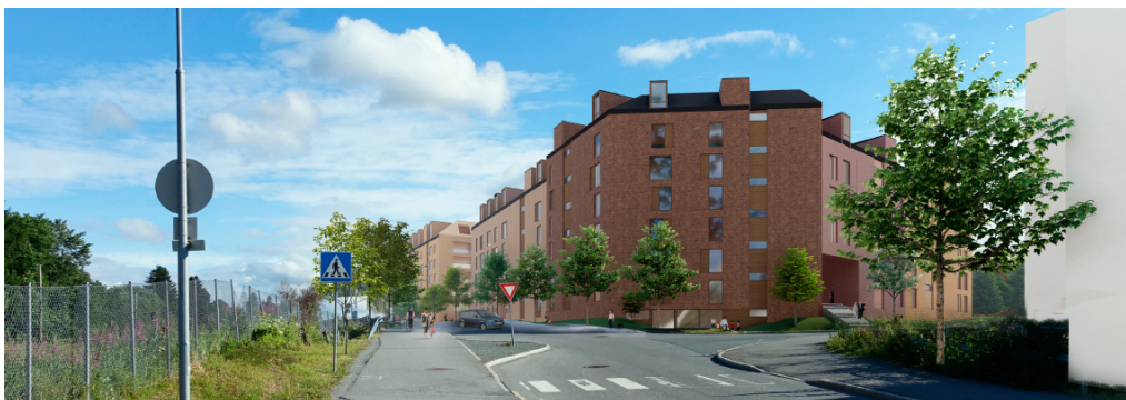
Foreslått prosjekt sett fra nord.
