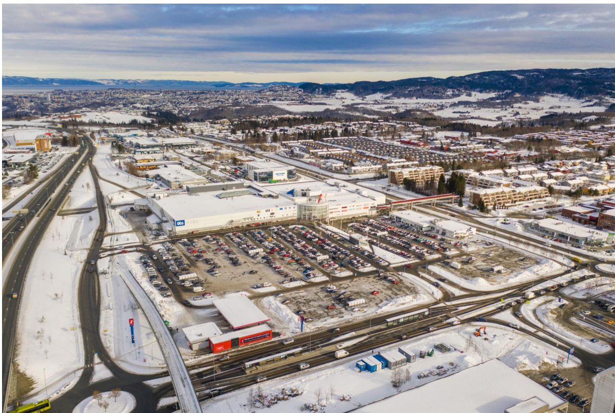
Figur 38: Dagens parkeringsanlegg på City Syd
