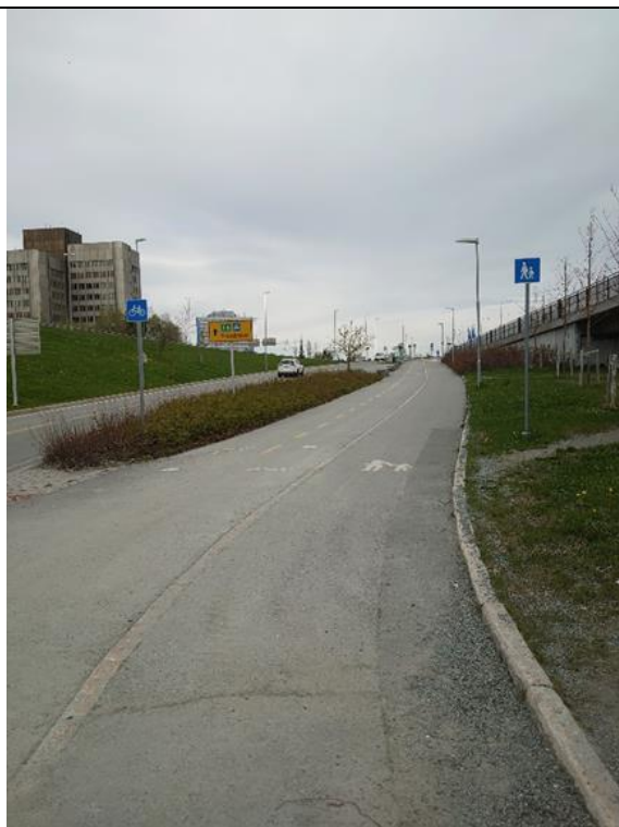
Sykkelveg med fortau langs E6-rampe fra Anne-Kath. Parows veg sett mot nord
