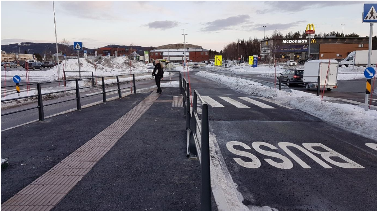
Figur 23: Gangfelt midt på Anne-Kath. Parows veg med kryssende busser til/fra Tillerterminalen med venstrekjøring (Foto: Asplan Viak)
