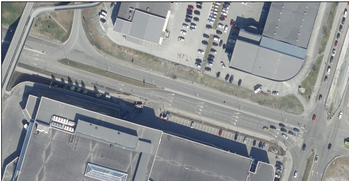
Figur 61: John Aaes veg nord for City Syd med fire kjørefelt inn mot krysset med Østre Rosten med signalanlegg
