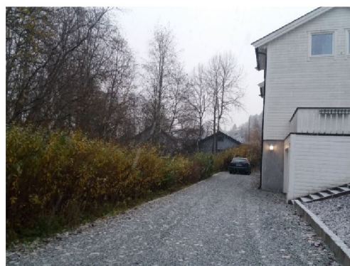
Bilde 4: gruslagt adkomstveg/biloppstilling med svakt fall inn mot Thaulowbakken.
