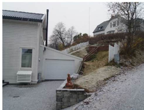
Bilde 2: potensielt kritisk punkt, hvor noe flomvann vil kunne renne inn på steinsatt uteområde. Som det framgår av bildet er det svakt fall fra vegkant mot senter veg.
