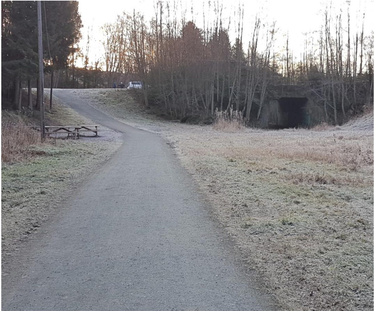
Figur 29: Eksisterende løype og sti helt i sør på delstrekningen. Forbindelse via eksisterende kulvert må reetableres.
