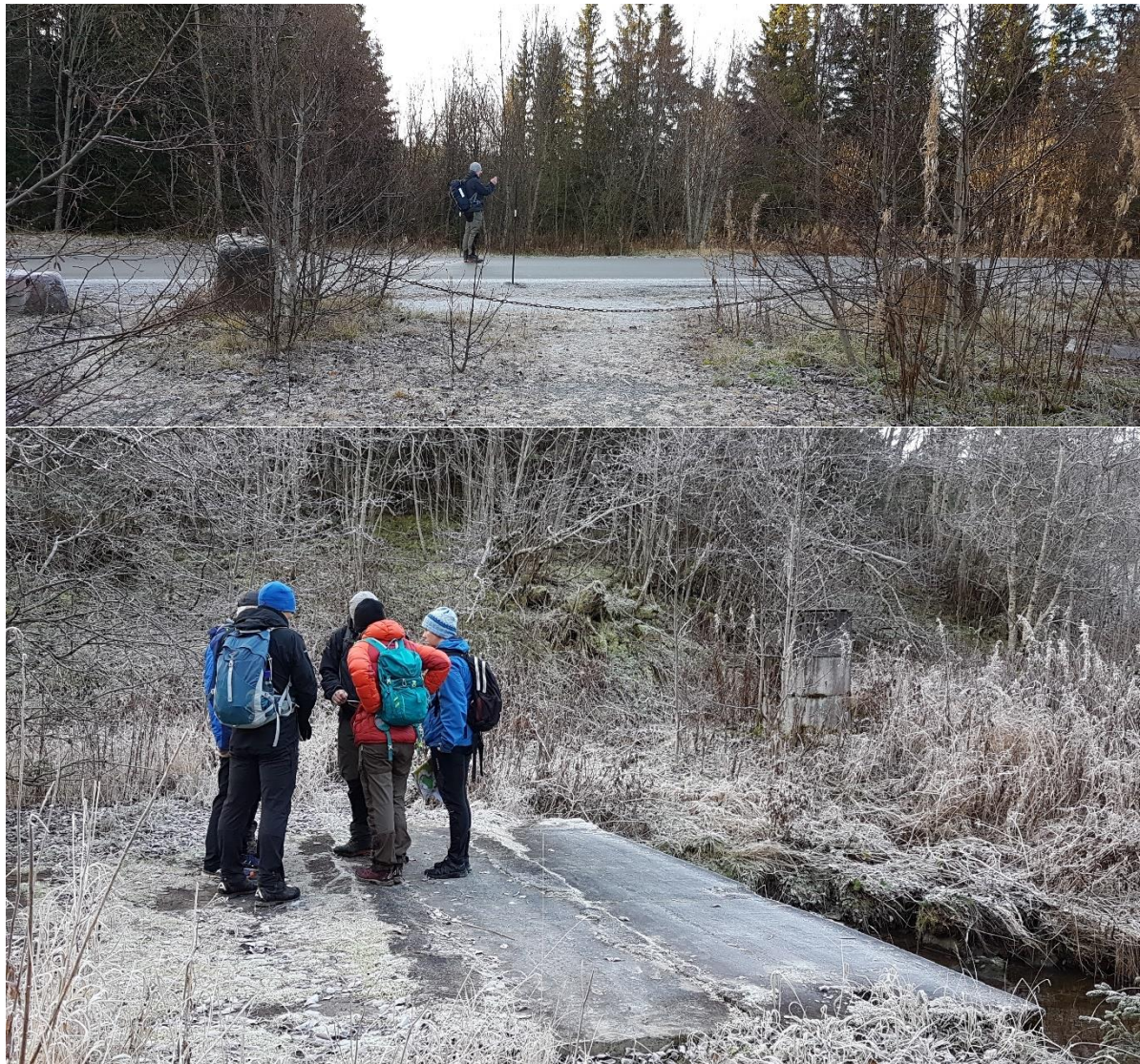
Figur 34: Kryssing av Tillerbruvegen må vurderes nærmere i neste planfase (bildet øverst). Det må etableres ny bru over Hårstadbekken, da dagens løsning ikke har en tilfredsstillende standard (bildet nederst).
