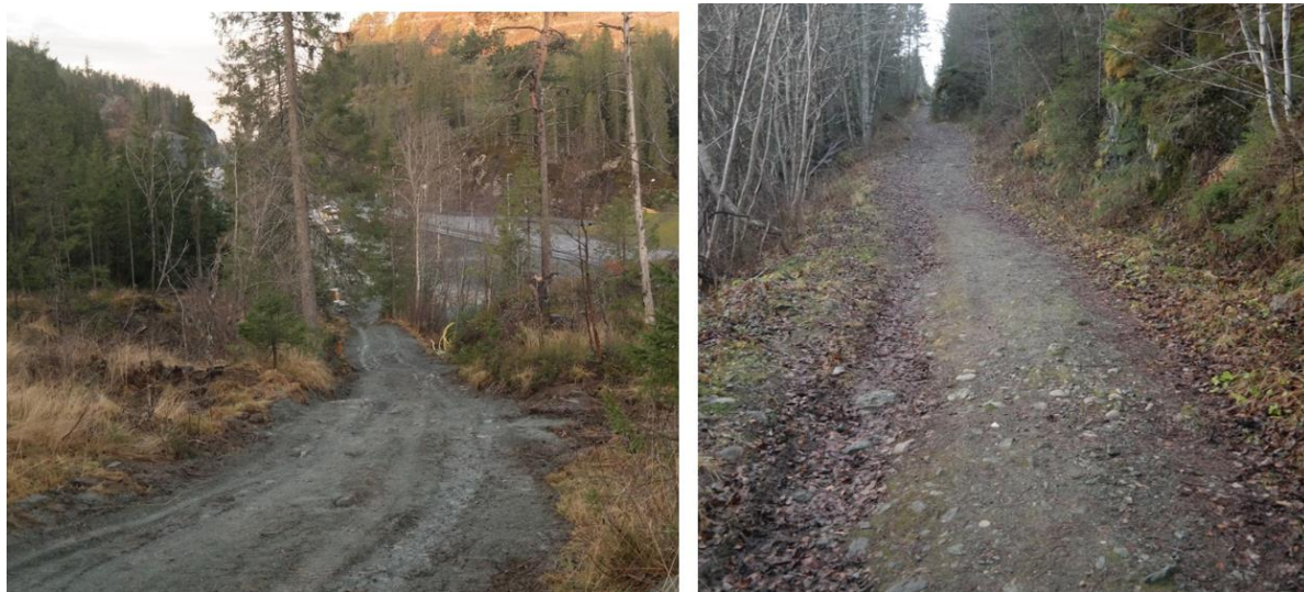
Figur 53: Eksisterende veg opp mot Vassfjellkapellet.
