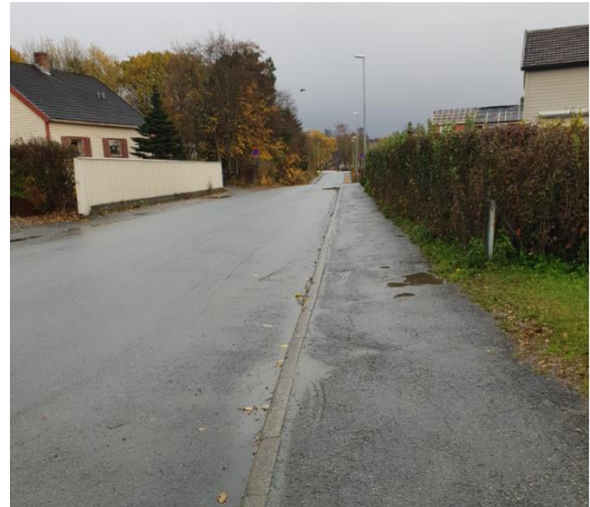
Figur 5 Fortau på nordøstlig side av Alette Beyers veg.
