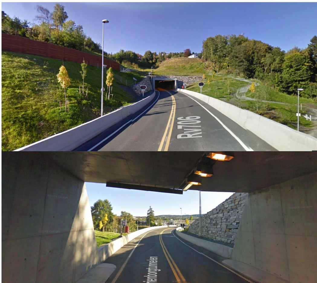
Figur 4 Tunnelåpning ved Nordre avlastningsveg. Bildene er hentet fra Google street view.
