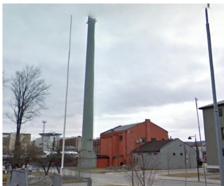
Figur 8 Bilde av Statkrafts forbrenningsanlegg på Marienborg
