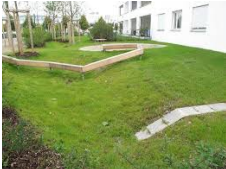
Figur 7: Nedsenket terreng som kan fordrøye overvann, Foto: Erling Holm, 2017
