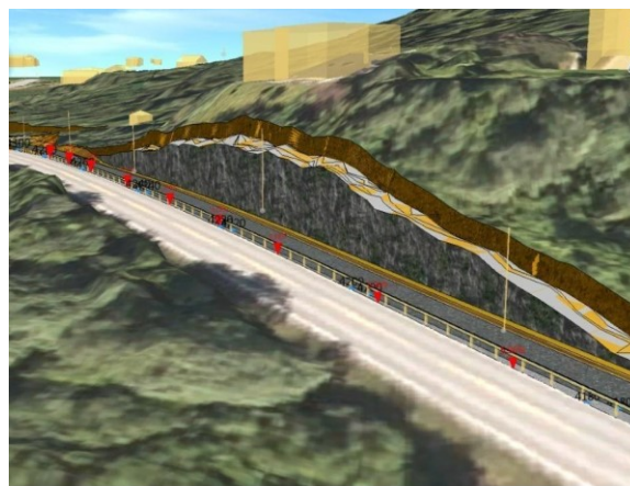
Fjellskjæring ved boliger
