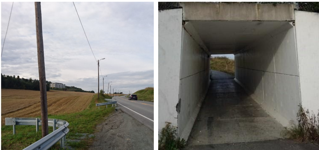
Lysmaster langs fylkesvegen ned mot Reppebekken og kulvert under fv. uten belysning.
