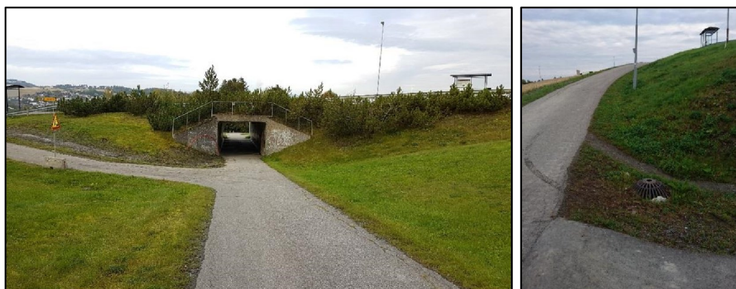
Figur 13 Undergang under fv. 950 Kockhaugvegen og bratt g/s-veg fra nordsiden av undergangen opp til bussholdeplassen.
