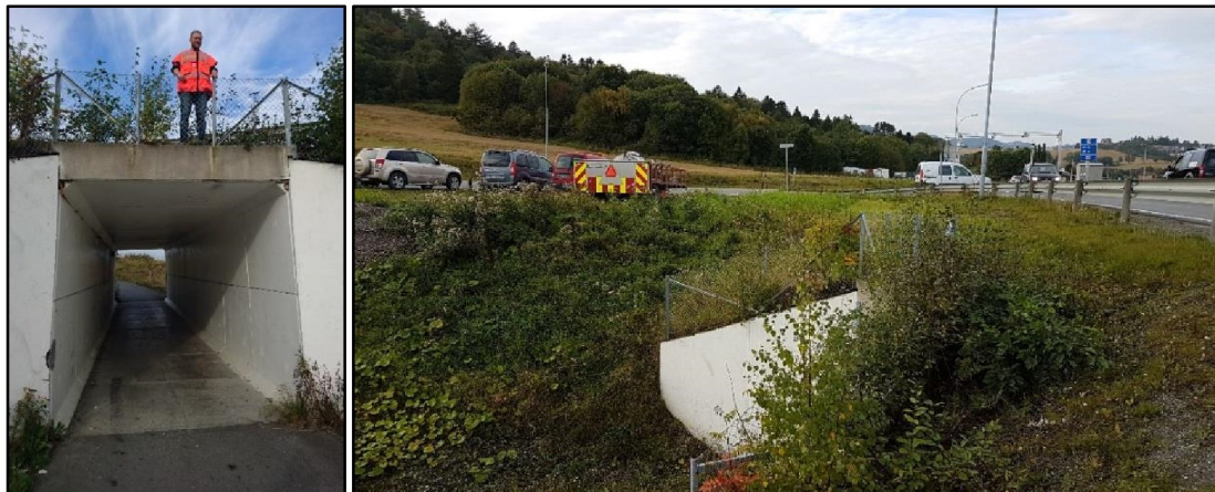
Figur 15 Undergang under fv. 950 Malvikvegen, Være
