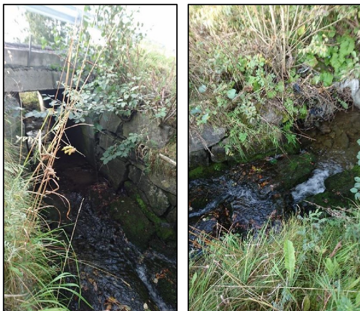
Figur 36 Reppesbekken og eksisterende kulvert under fv. 950 (Foto: Birgisson)
