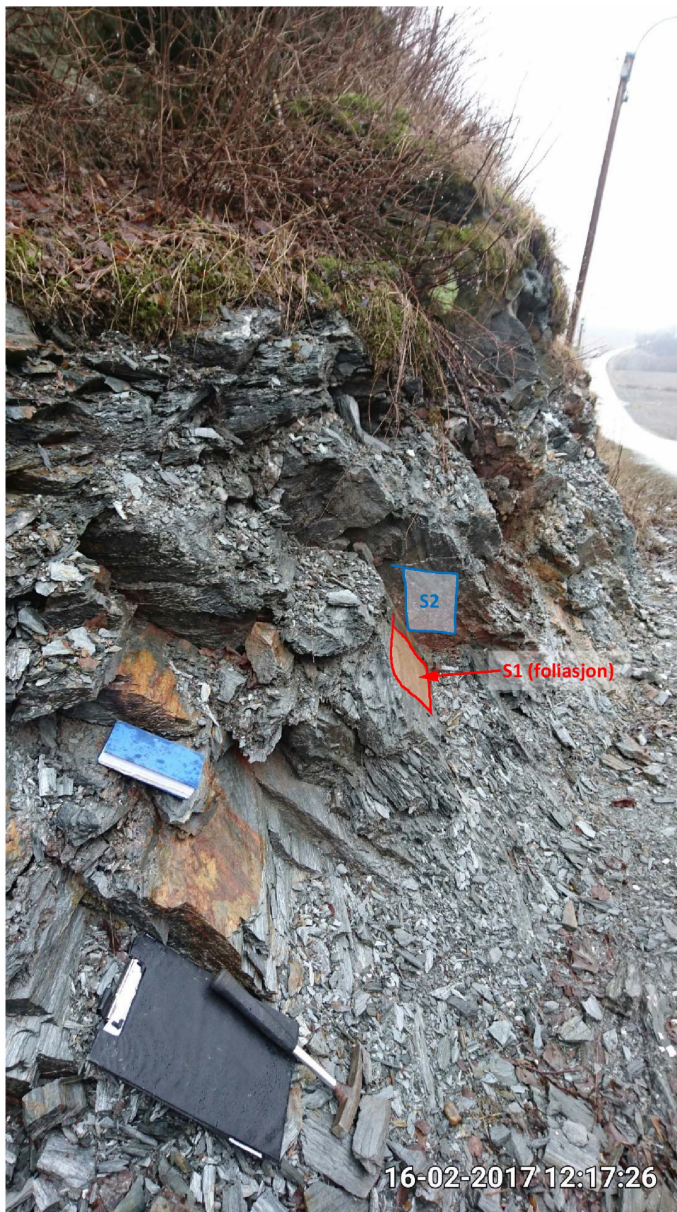
Bilde 3: UkjentVeg_20170216_121726DFyllitt i eksisterende bergskjæring på sørsiden av fv. 950 (sett mot vest, synkende profil). Tett oppsprekking langs foliasjon, rust på enkelte sprekkeflater. Dominerende sprekkesett S1 (foliasjon) og S2 er vist.
