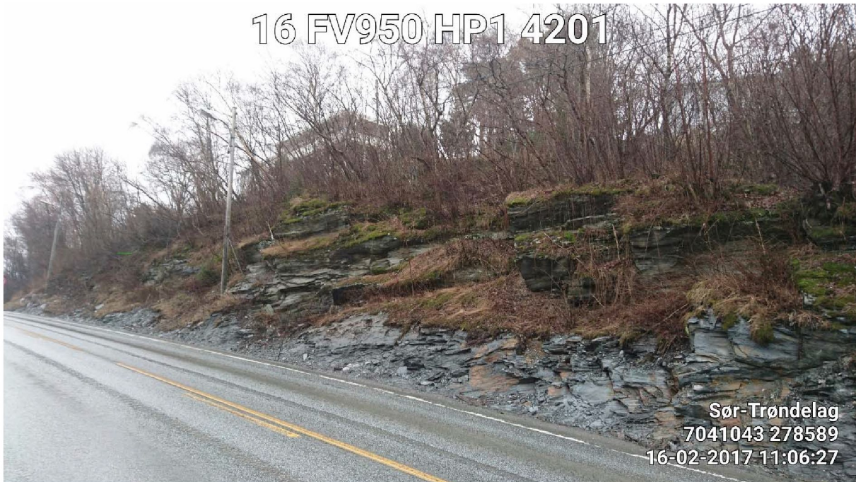
Bilde 1: 1600_FV950HP1M4201_20170216_110627 Oversiktsbilde av eksisterende bergskjæring på sørsiden av fv. 950. Sett mot øst (stigende profil). Boligen i Furuhaugen 6 (Værestien 5) skimtes på toppen av bergskjæringen.
