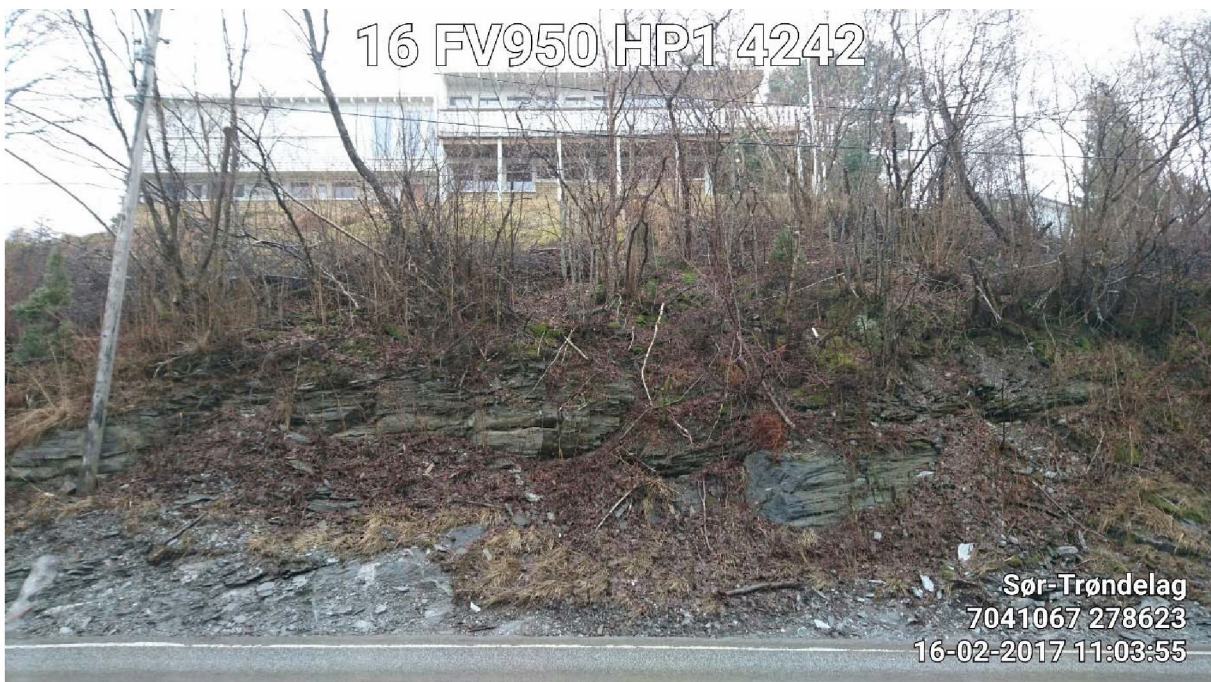
Bilde 2: 1600_FV950HP1M4242_20170216_110355 Deler av eksisterende bergskjæring omkring hp 1, km 4,242 (eksisterende kilometrering langs fv. 950). Sett mot sør. Boligen i Furuhaugen 6 (Værestien 5) står på fylling som kan bli berørt av utvidelse av eksisterende bergskjæring.
