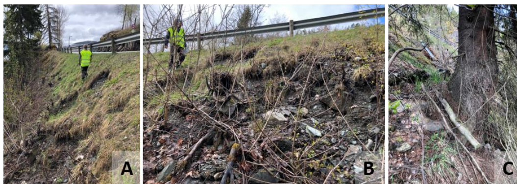
Figur 5. A og B: Mindre utrasinger i løsmasser rett nedenfor Bynesveien, se også Figur 3. C: Skjev stamme på stort grantrø indikerer sig i øvre deler av løsmassene.
