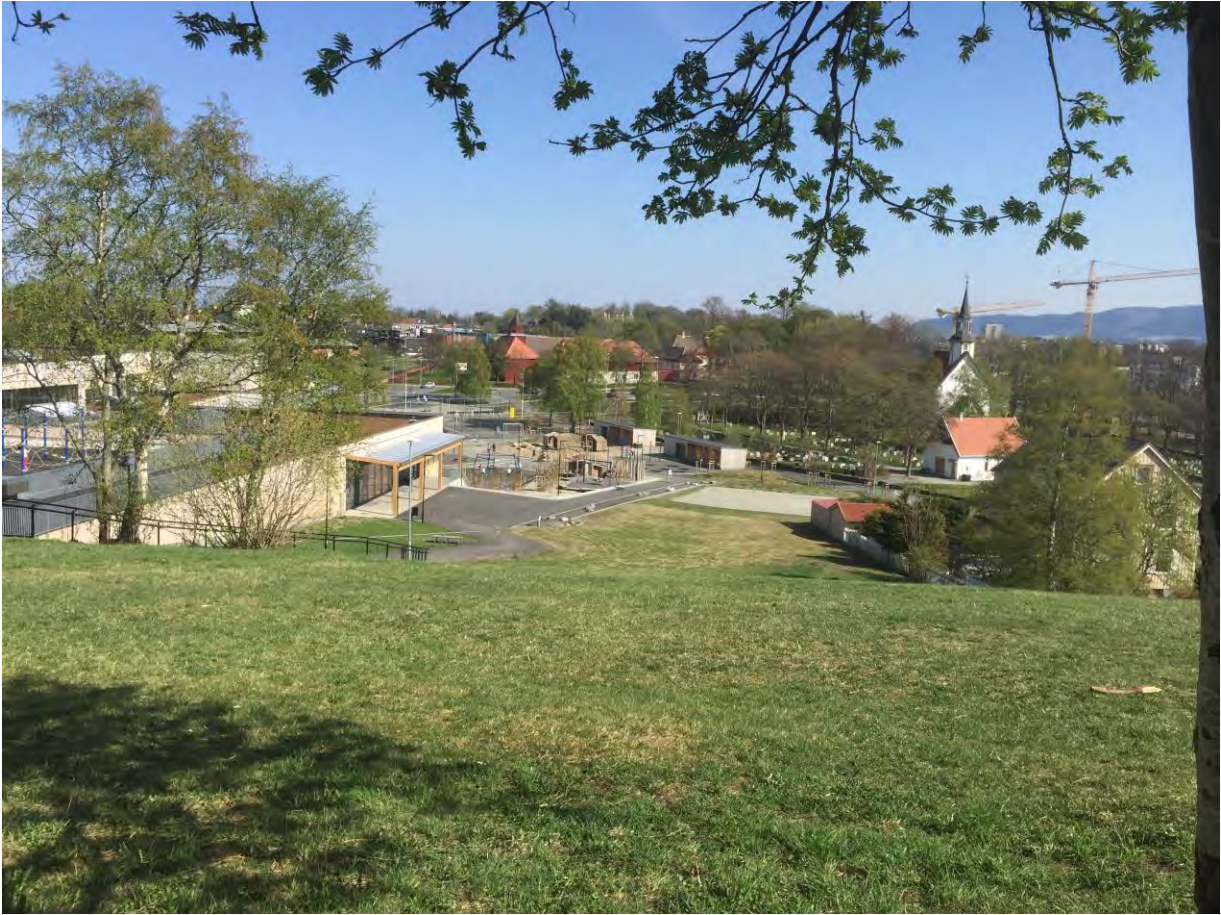
Fra Grønliia mot Rognli og Ringve gård. Bildet viser tydelig hvordan Lade skole er plassert i forhold til Lade kirke og hvordan ny bebyggelse nord for Lade gård ikke forstyrrer gårdsbebyggelsen.
