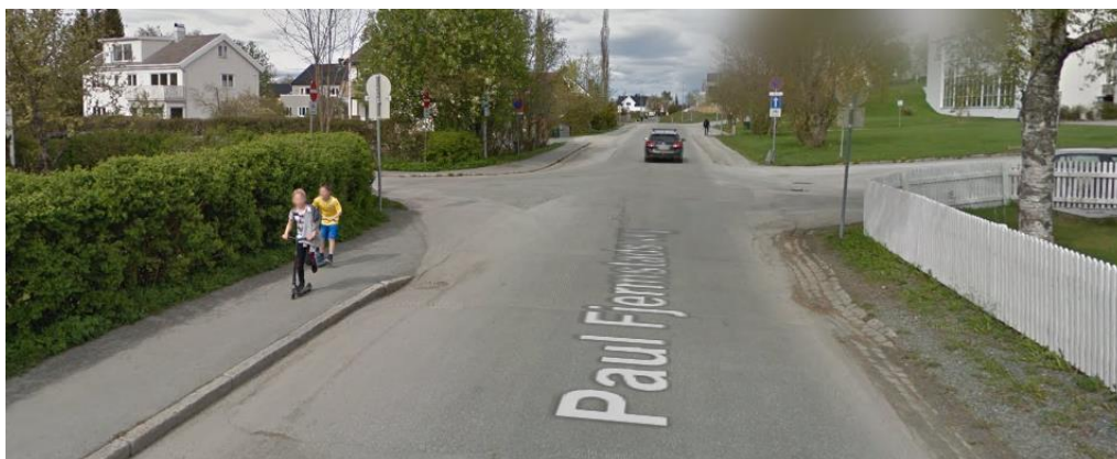
Figur 21: Dårlig sikt i krysset, og ingen tilrettelegging for myke trafikanter som skal krysse.
