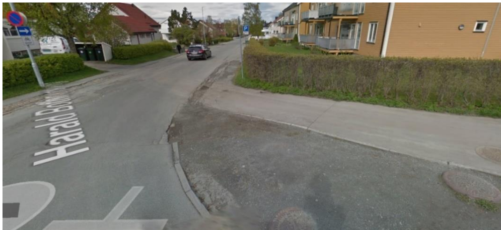
Figur 18: Fortauet på nordsiden av Otto Nielsens veg fører myke trafikanter til et smalt fortau som strekker seg noen meter oppover før det avsluttes i kantparkering.
