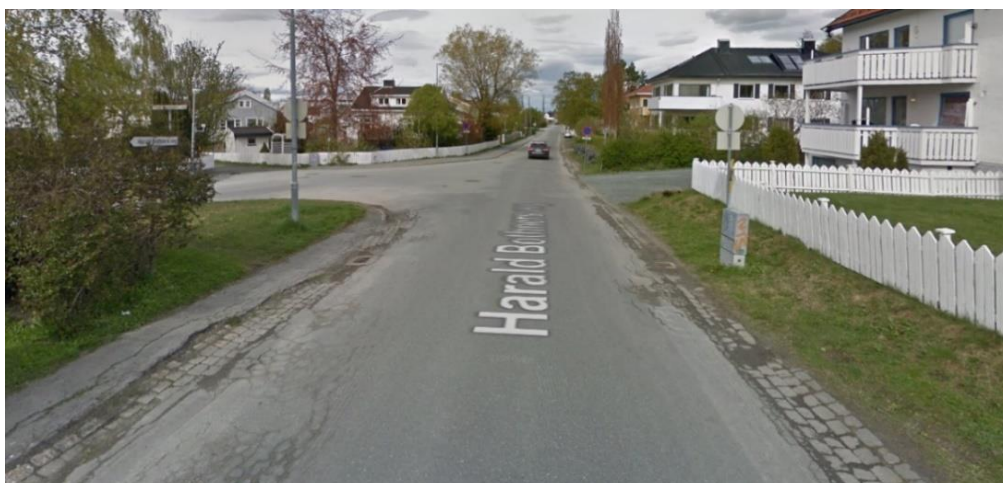
Figur 19: Harald Bothners veg, går over til Paul Fjermstads veg. Ensidig, smalt fortau av dårlig kvalitet. (Google maps, mai 2019)
