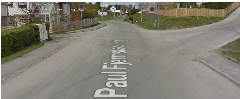
Figur 23: Dårlig løsning for myke trafikanter som benytter fortauet. Fortauet på høyre side avsluttes før krysset.
