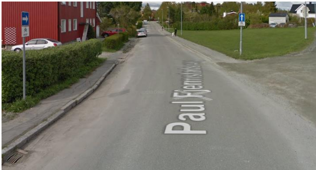
Figur 25: Smalt fortau på venstre side som er omtrent 0,5 meter bred og ingen tydelig kryssning for myke trafikanter.
