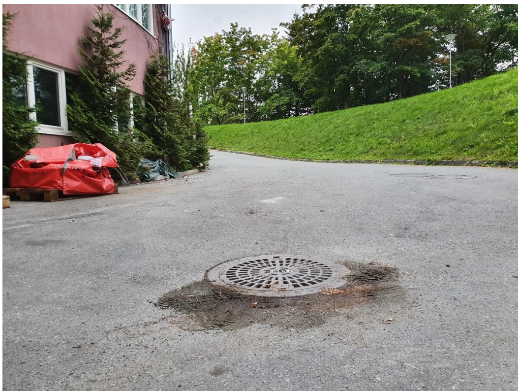
Figur 12. Sluk i områdets laveste punkt ved nedkjøring til kjeller. Om denne blir tett kan dette lede til oversvømmelse.
