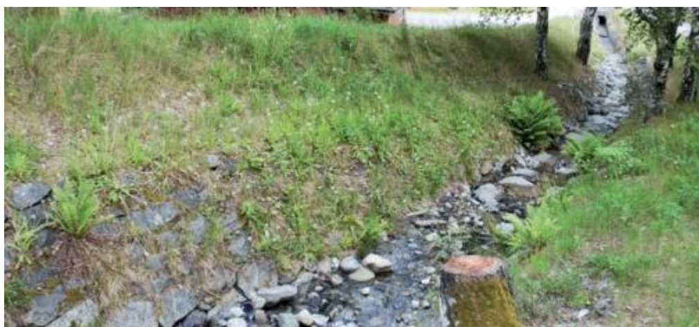
Figur 27. Bekk i bratt terreng sikret med erosjonssikring av stein.
