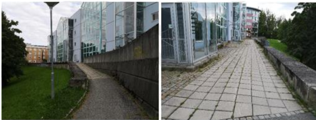
Figur 20: Bildet til venstre viser fortauet opp mot Elektrobygget, bildet til venstre er sett mot Sem Sælands vei 11 og viser hellelagt område
