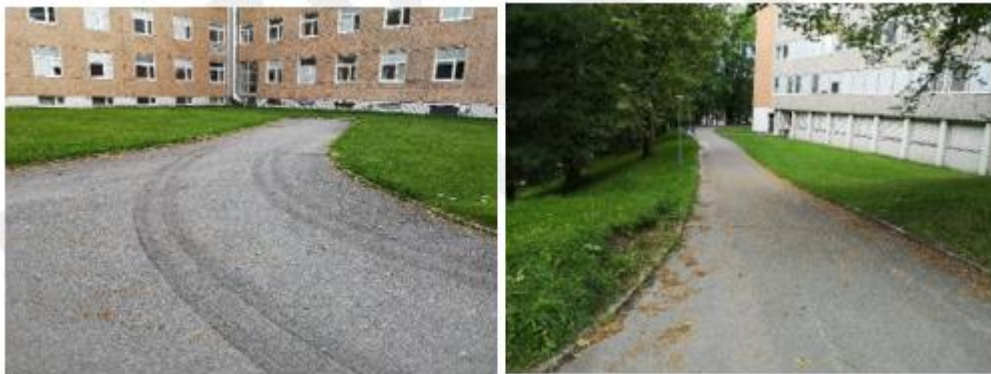
Figur 22: Snuhammer til venstre og GS-veg som går mot O. S. Bragstads plass til høyre.
