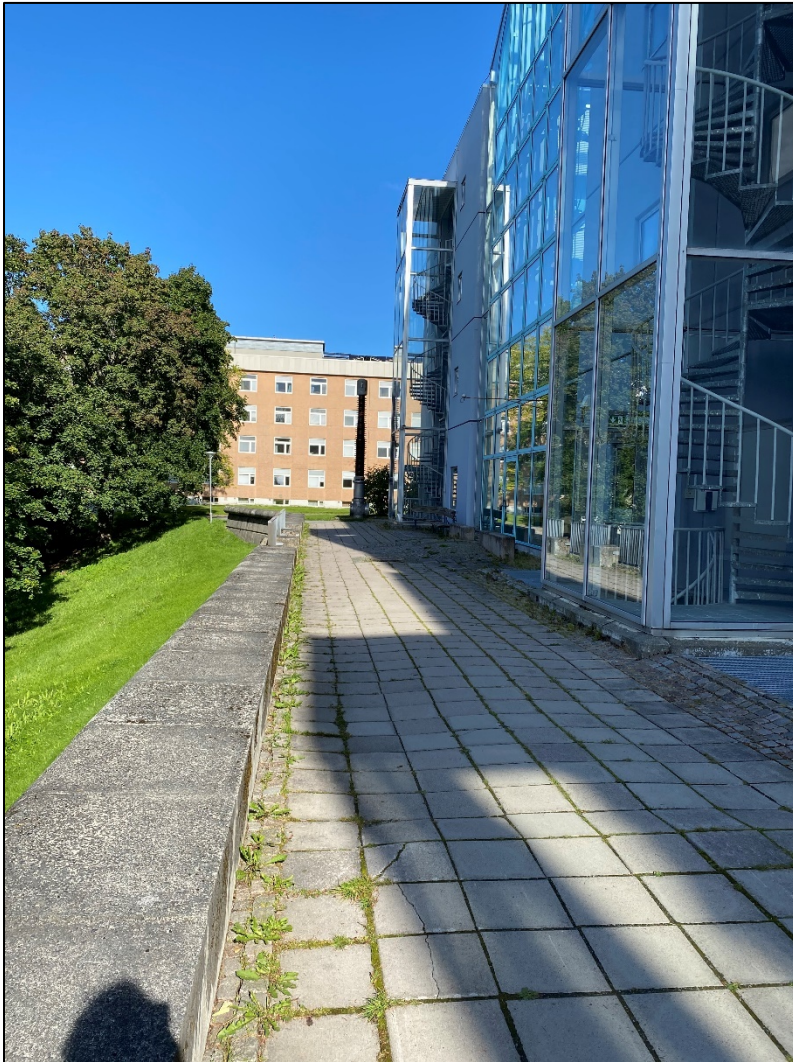
Figur 10 Dagens løsning ved elektrobygget
