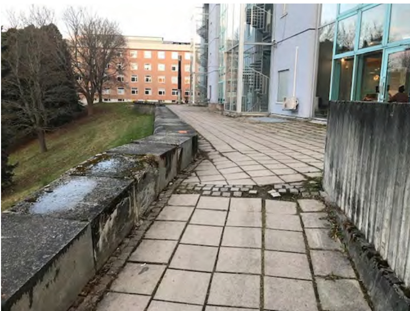
Figur 7: Smalt parti som må utbedres foran Elektrobygget.
