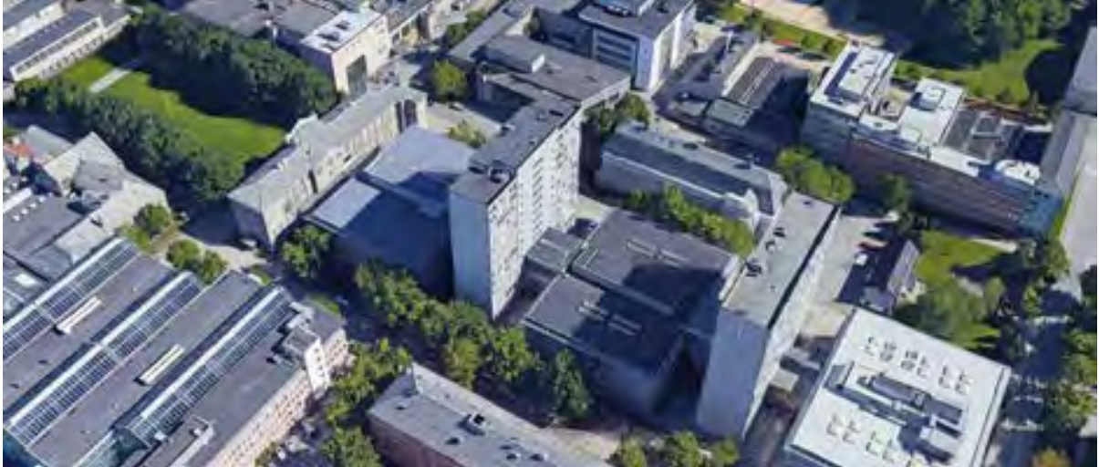
Figur 6. Sentralbygga med mellombygg. Google Maps (3D).
