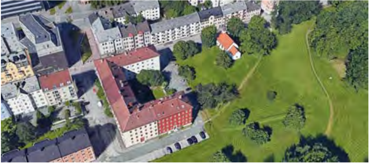
Figur 7. Verneverdig bustadblokk og Døvekyrkja, skråfoto. Google Maps (3D).
