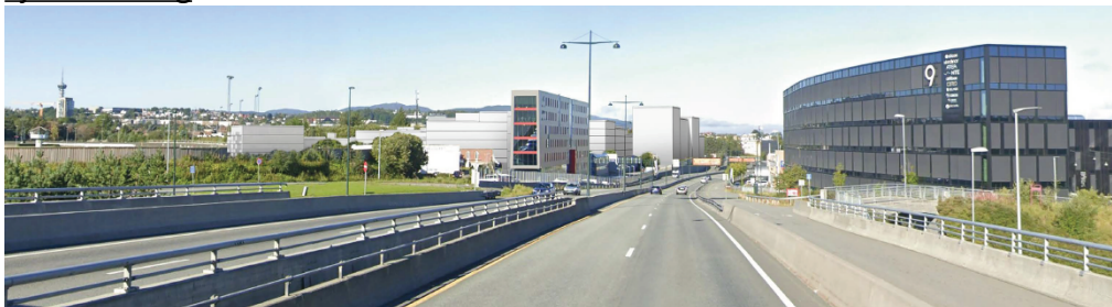
Figur 16: Planområdet sett fra Innherredsveien østfra
