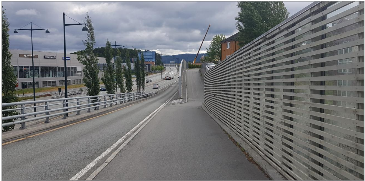
Figur 13: Gang- og sykkelveg/ fortau langs Innherredsveien
