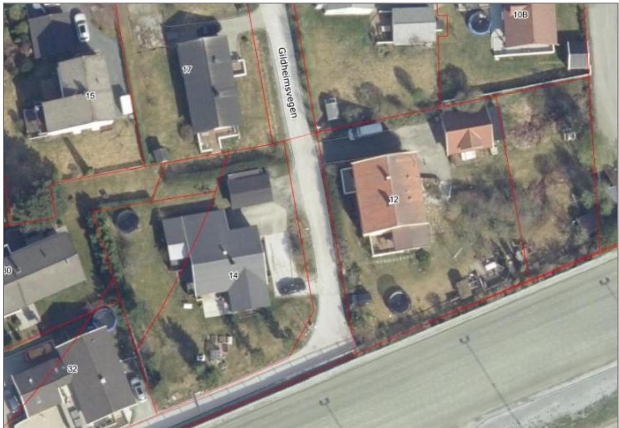
Figur 43: Flyfoto der eiendomsgrense mot nr. 1 illustrerer strekningen der Gildheimsvegen bør utvides
