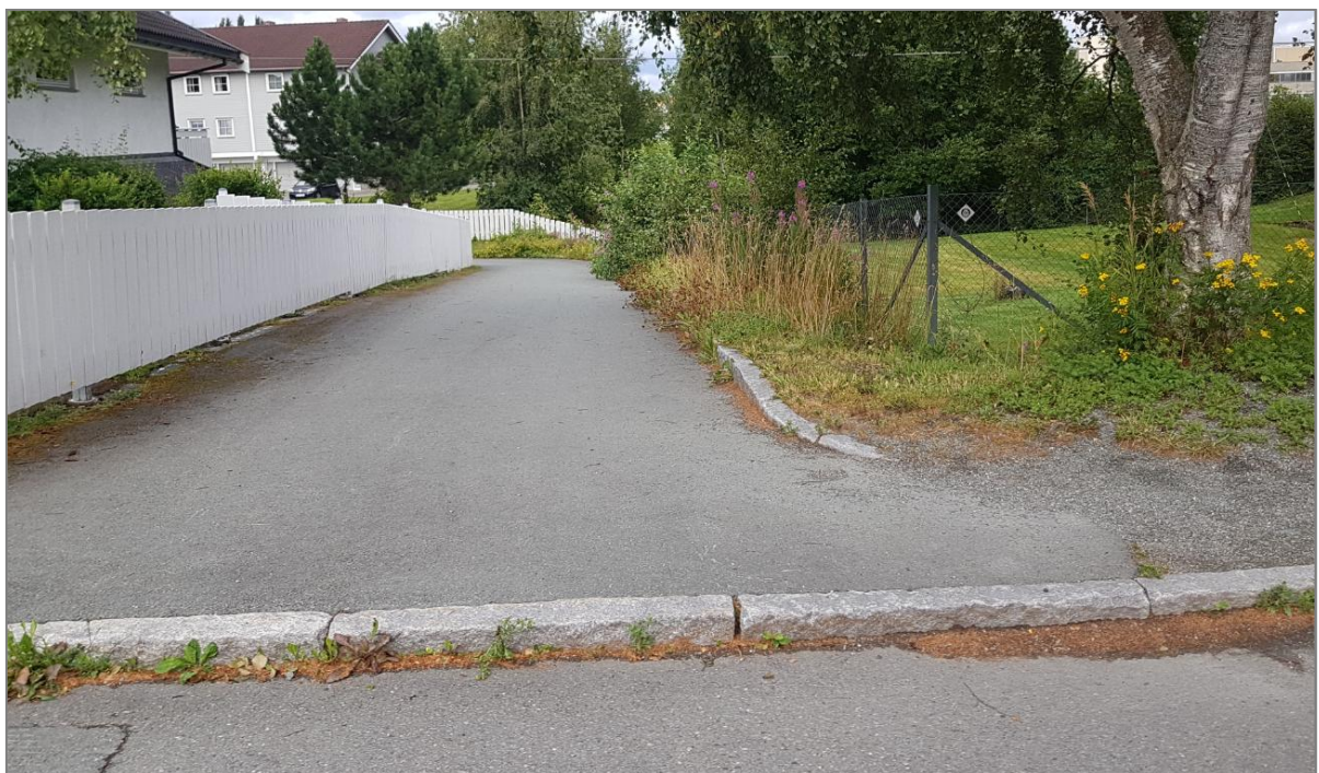
Figur 18: Gangveg fra Brøsetvegen til Belbuvegen
