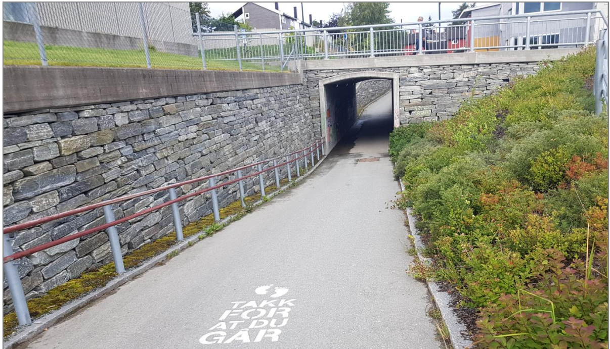
Figur 21: Undergang under Bromstadvegen ved Strindheim skole
