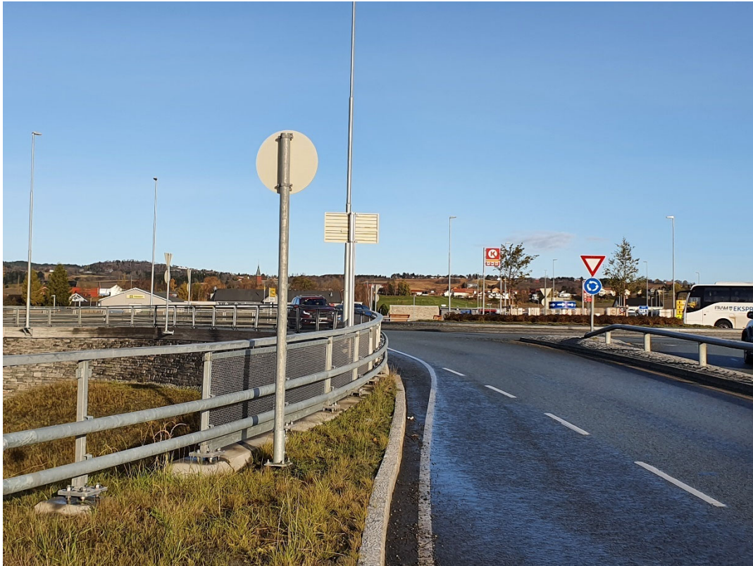
Sett fra det nye Klett krysset. Kjørefelt, skilt og rekkverk dominerer i synsfeltet og landskapet omkring er lite fremtredende. Grav- og urnelunden ligger skjult bak Leinstrand kirke.
