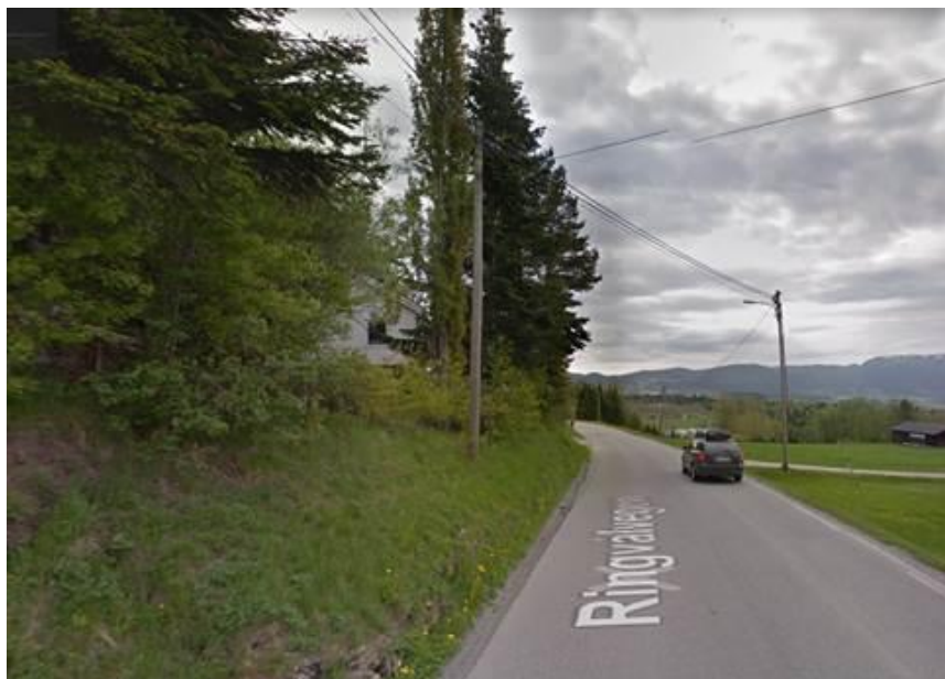
Figur 19: Eksempel på hvor utvidelse til sykkelveg med fortau vil kreve inngrep i terreng og grunnerverv ved Ringvålvegen 110
