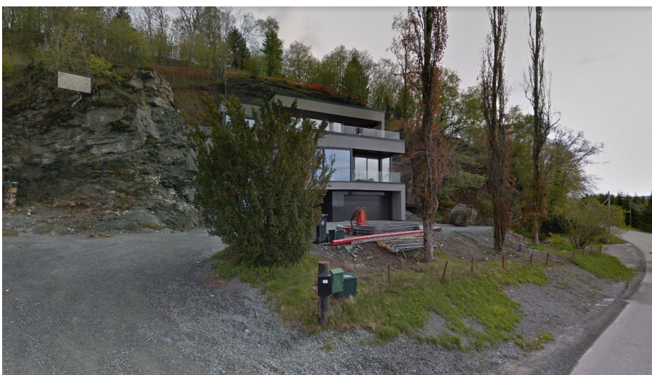
Foto 10: Ringvålvegen 116 med sprengt skjæring i bakkant (foto: Google maps)
