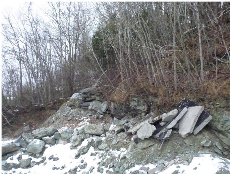
Foto 4: Skjæring/fylling i delområde B
