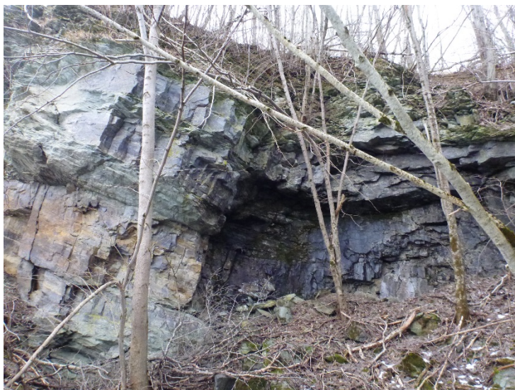
Foto 5: Skjæring (steinuttak?)/fylling i delområde B
