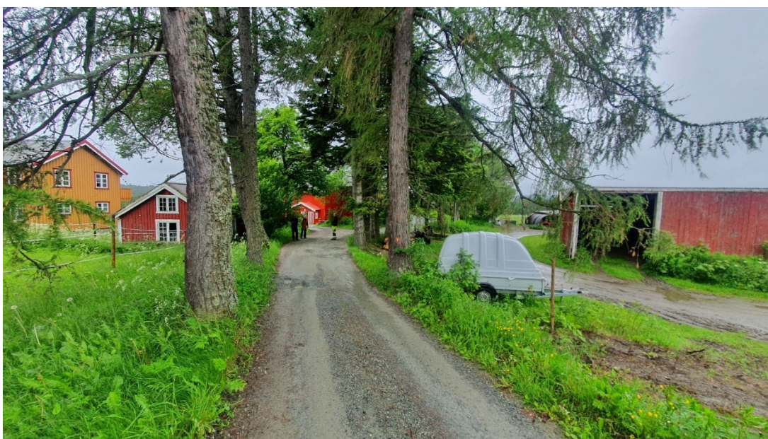
Partiet hvor vegen går mellom to gårdstun. Et tun på hver side av vegen.
