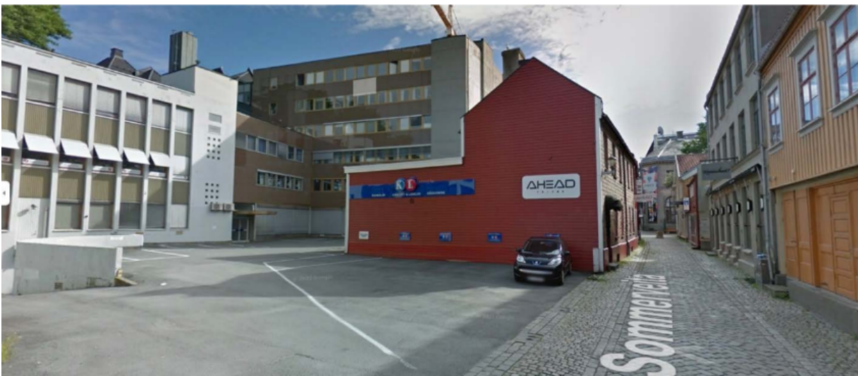
Eksisterende situasjon sett fra vest mot øst i Sommerveita.
