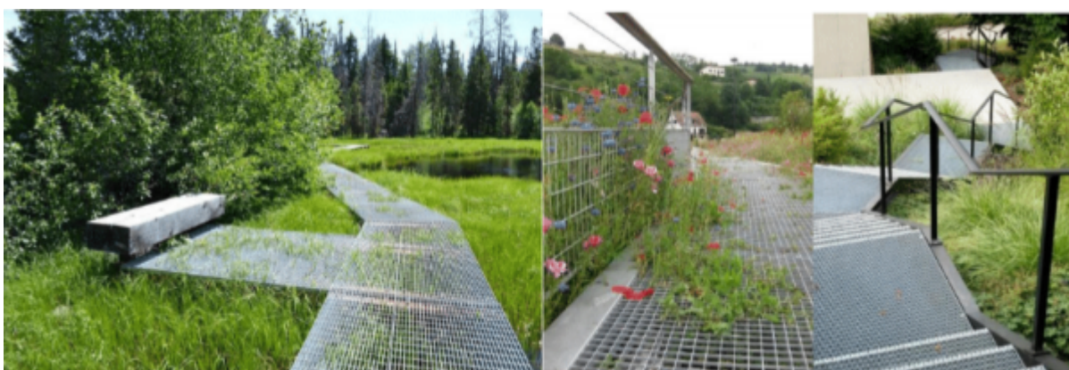
Bildene viser løsning med gitterrist. hvor vegetasjon får vokst gjennom.
