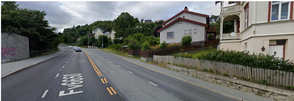
Figur 3 På tur opp Byåsveien, Sverre Hassels vei til høyre, Google aug 2023
