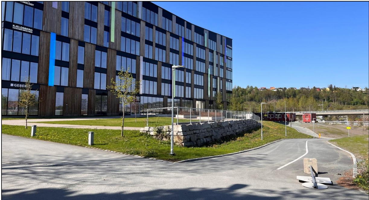
Figur 10. G/S-vei som går under E6/Omkjøringsvegen, med Lysgården i bakgrunnen. Bekken legges mellom G/S-veien og Lysgården, mur fjernes. (Foto: Grindaker)
