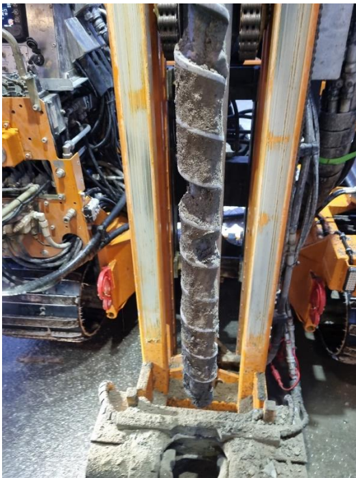
Figur 5-2: Borhull M2 (2,0-3,0 meter under terreng), med et ca. 0,7 meter mektig lag med stedege strandavsetninger over et 0,3 meter mektig underliggende lag av silt/leire.
