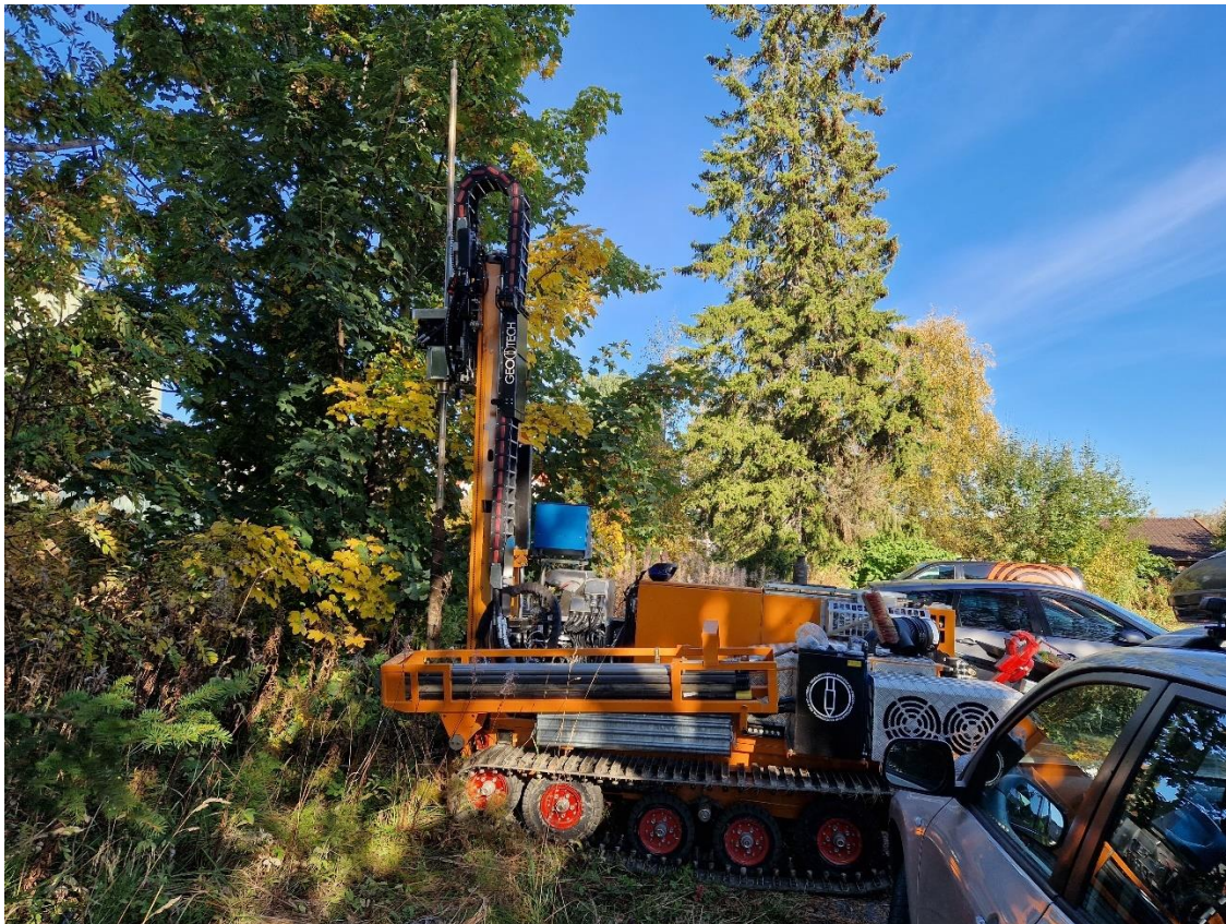
Figur 20: Grunnboring ved B1. Bildet er tatt mot nord.
