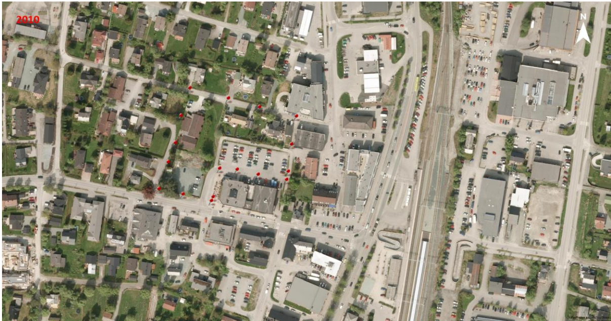
Figur 15: Flyfoto fra 2010 med tiltaksområdets beliggenhet markert med rød knappål. Tiltaksområdet er preget av eneboliger, kjøpesenterets parkeringsplass og grøntområder. Tiltaksområdets sørvestlige del benyttes som parkeringsplass. ©Kartverket
