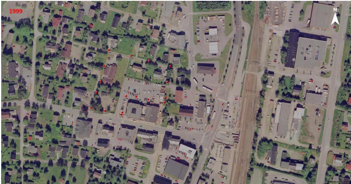
Figur 13: Flyfoto fra 1999 med tiltaksområdets beliggenhet markert med rød knappemål. Tiltaksområdet er preget av eneboliger, kjøpesenterets parkeringsplass og grøntområder. Tiltaksområdets østlige del er preget av anleggsvirksomhet, trolig i forbindelse med etablering av tilbygget til kjøpesenteret. ©Kartverket
