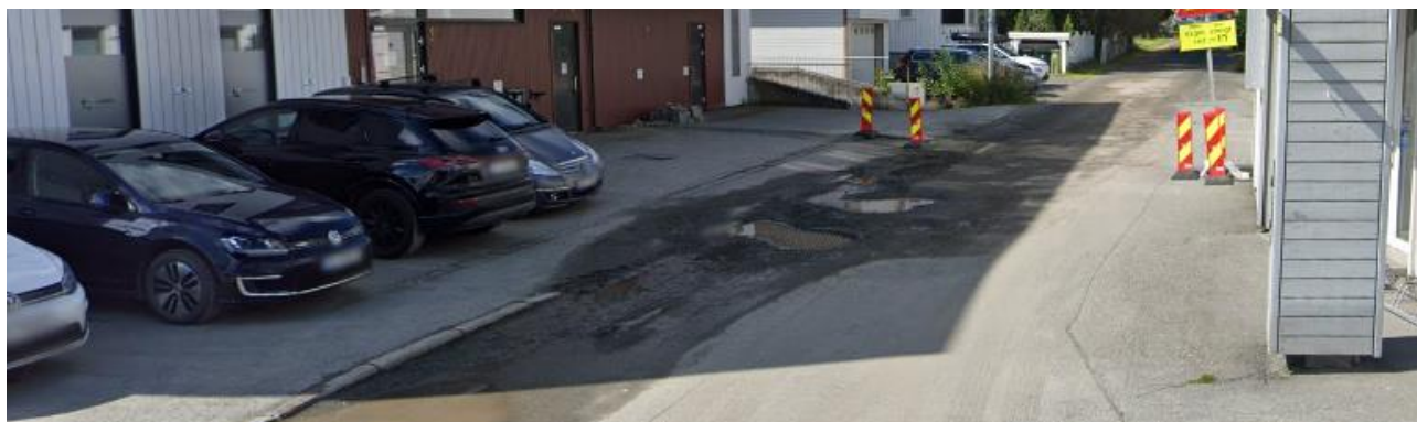
Figur 5: Utforming av J.O. Stavs veg nærmest Søbstadvegen. Skjermdump fra Google Street View aug. 2022.
