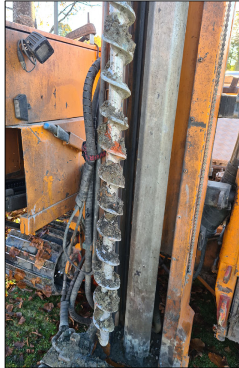
Figur 21 SPA8 1-2 meter. Jord, sand og grus med innslag av tegl.
