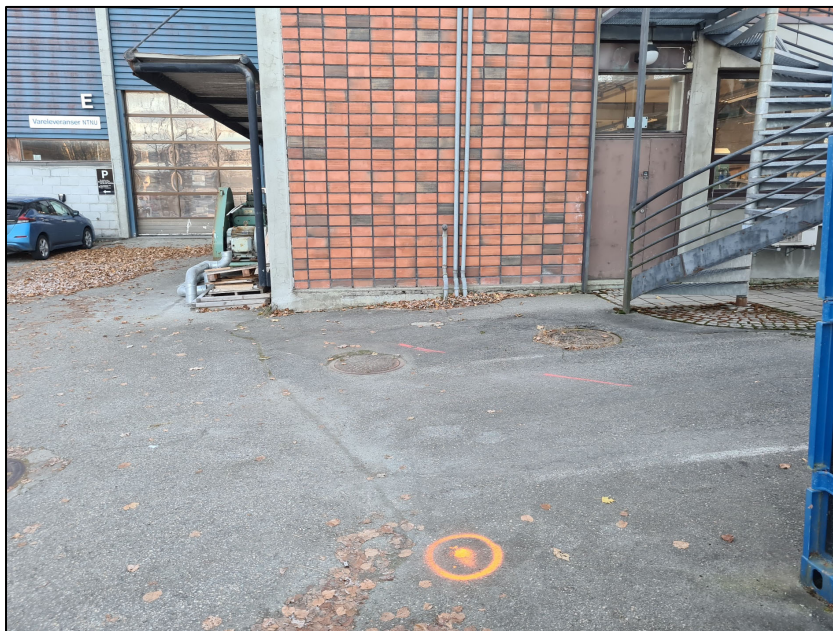
Figur 25 Lufterør for nedgravd tank på sørvestre fasade av PTS hallbygg.
