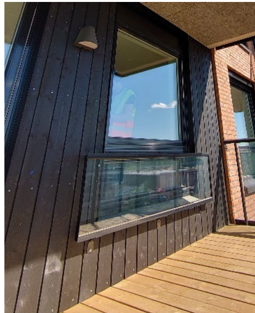
Figur 11 - Nærbilde av lokal skjerm foran fasade.
