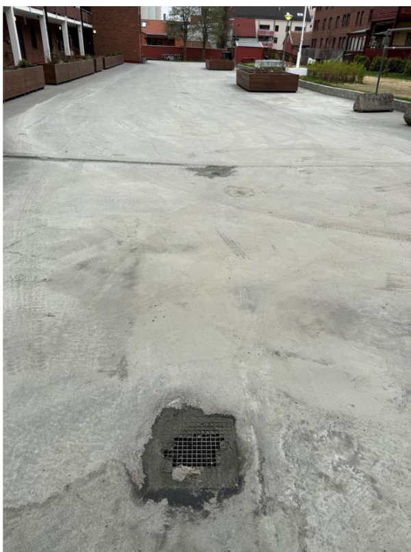
Utsnitt av eksisterende sluk i bakgård. Disse antatt ledes til P-kjeller under asfaltert areal. Se beskrivelse på neste.
