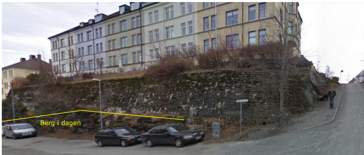
Figur 5. Støttemur ved kryssing mellom Gyldenløves gate og Øvre Møllenberg
