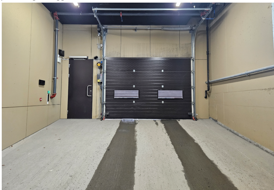
Eksisterende port og nedkjøringsrampe i tilgrensende plan.
