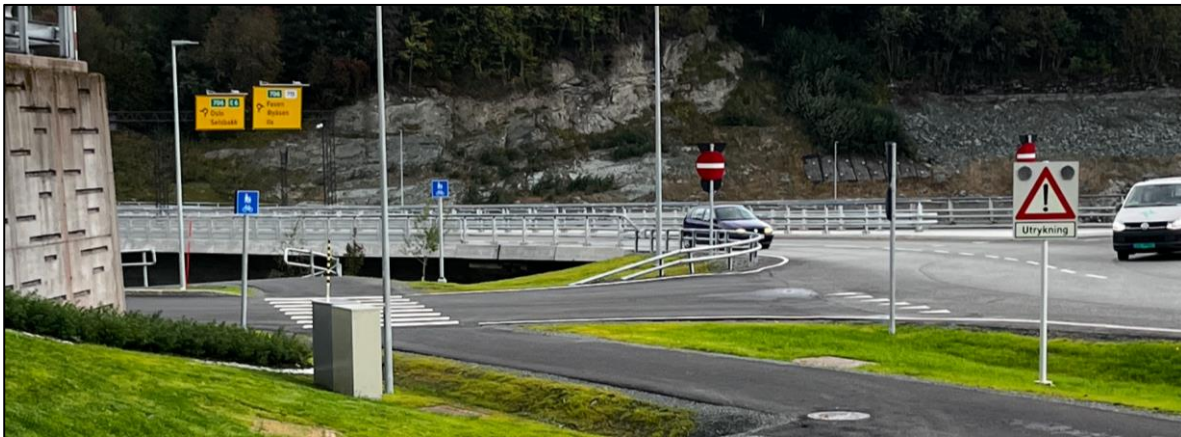
Figur 2-14 Situasjon ved gangfelt ved hovedadkomst med varselskilt til høyre. (Foto: Sweco Norge AS)
