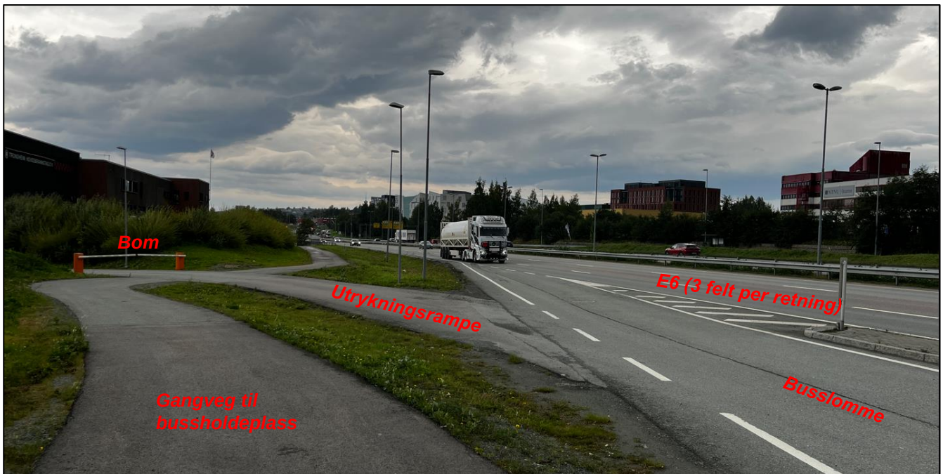
Figur 2-2 Oversikt over utrykningsrampen som ender i busslommen langs E6 (Kroppanbrua), med tilhørende gangveg på østsiden av hovedbrannstasjonen. (Foto: Sweco Norge AS).
