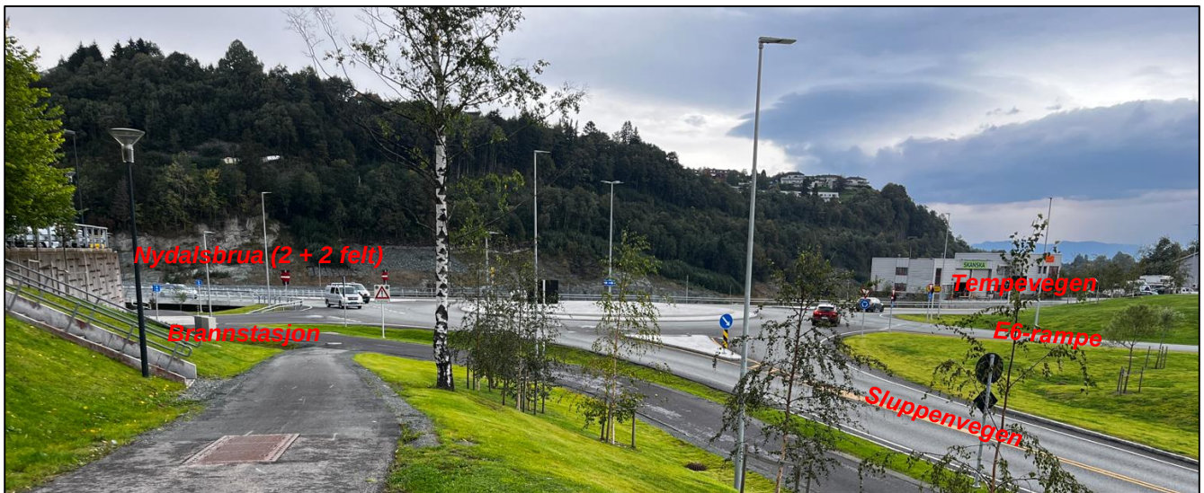
Figur 2-3 Oversikt over adkomstrundkjøringen sett fra gangveg på østsiden av hovedbrannstasjonen. Trapp opp til hovedinngang er til venstre ved lyktestolpe i bildet. (Foto: Sweco Norge AS)
