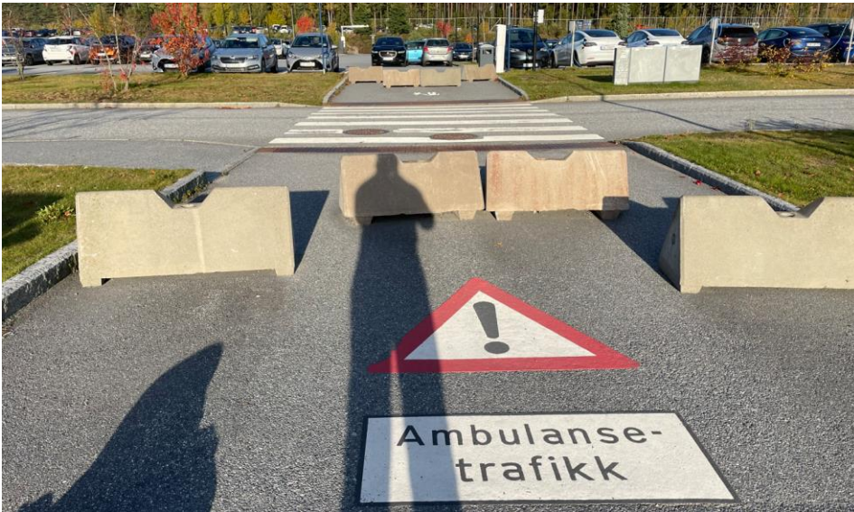
Figur 4-7 Foto av gangfelt med tilhørende tiltak for å øke fokus for de som krysser ambulansesadkomsten til Sykehuset Østfold på Kalnes i Sarpsborg (foto: Sweco Norge AS).
