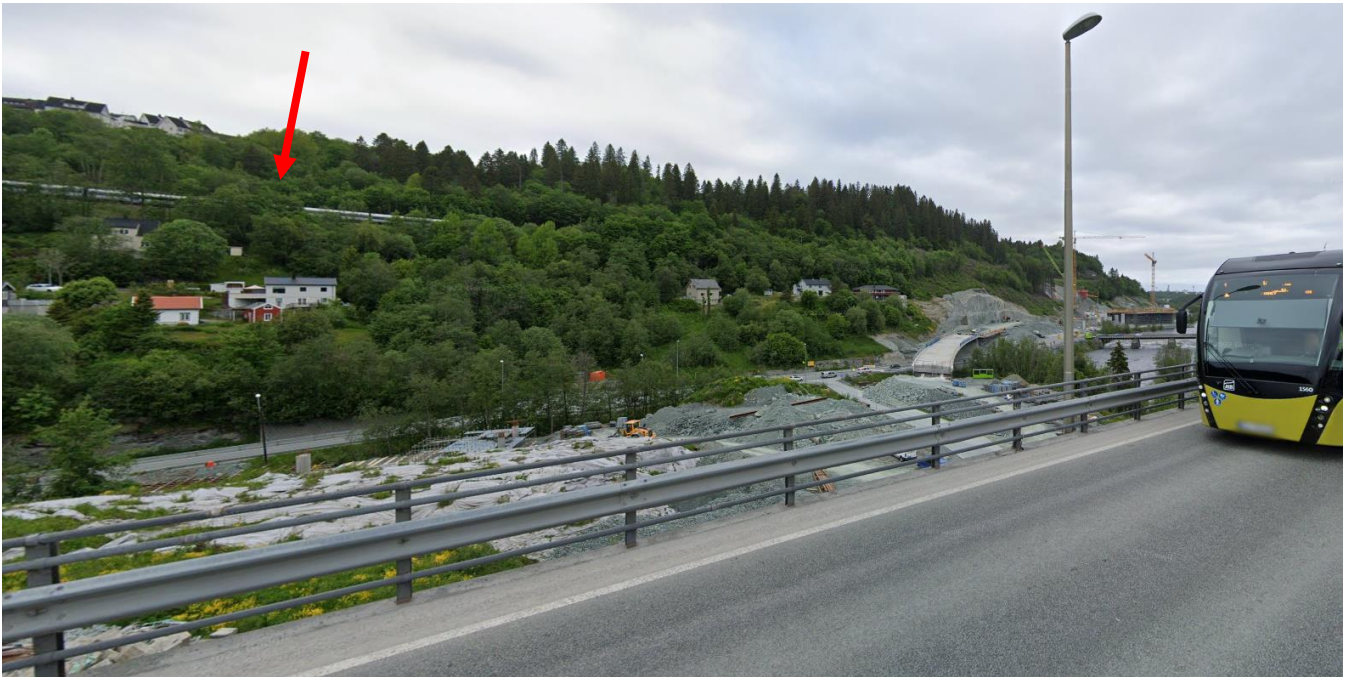
Figur 4-1 Gatebilde fra E6 Sluppenbrua fra juni 2022 hvor det passerer tog oppe i dalsiden mot Byåsen. Kilde: google streetview.
