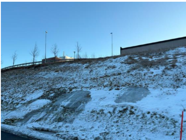
Figur 3-14: Observasjoner fra befaring utført 11.02.2025 som viser tydelig vanntransport ut av skråningen.
