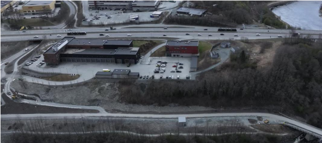
Figur 3-2: Dronebilde over tomten, sett fra vest. Kilde: Trøndelag brann- og redningstjeneste, 2024.
