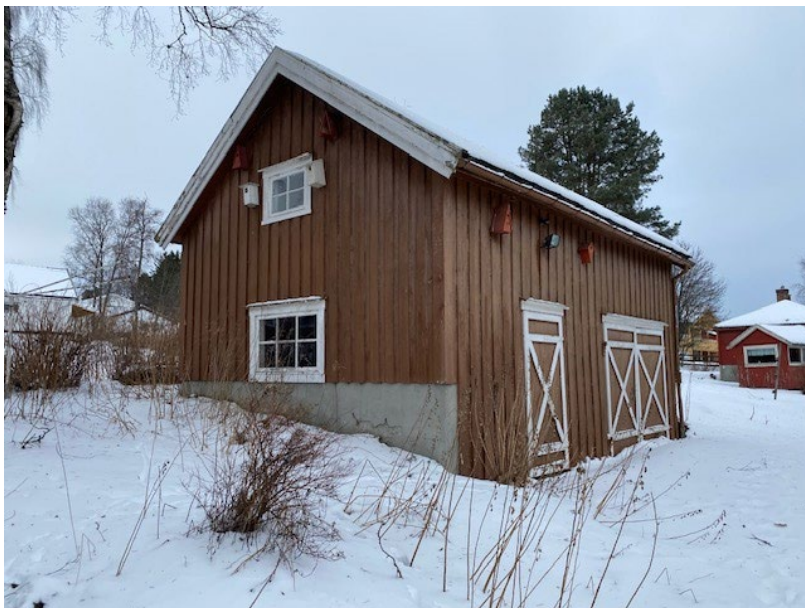
Garasje/ redskaps hus er ikke befart innvendig.
