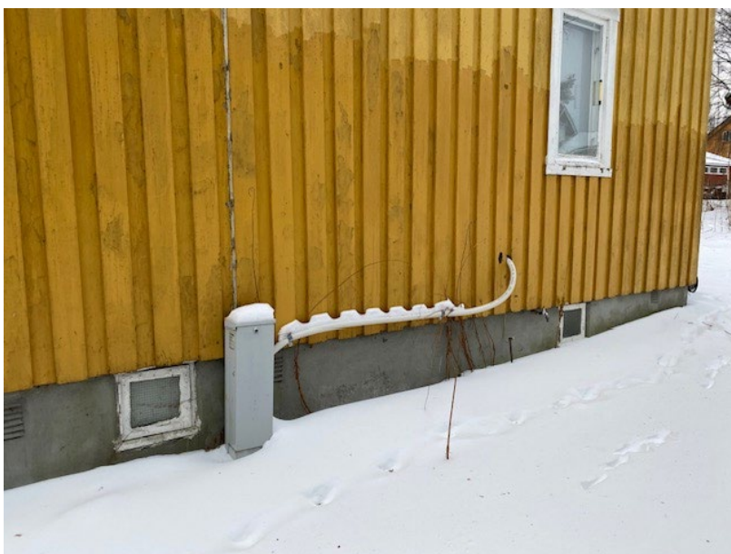
Nytt strøm inntak på nordvegg. Tidligere luftstrek er erstattet med jordkabel
