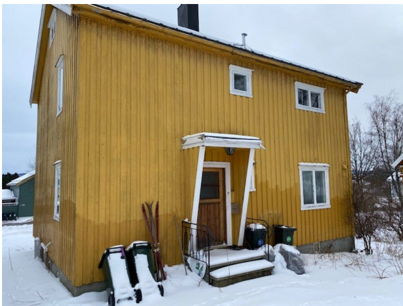
Fasade vest med inngangsparti
