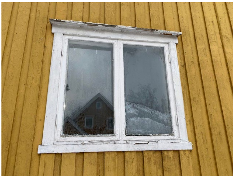
Vinduer fra byggeår. Enkelt glass med kittfals.
