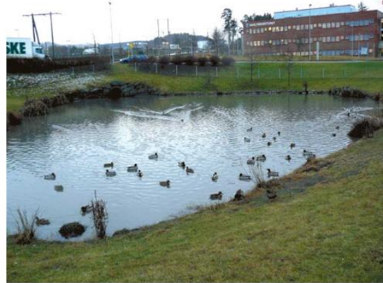
Figur 5: Åpen dam for fordrøyning (SINTEF)
