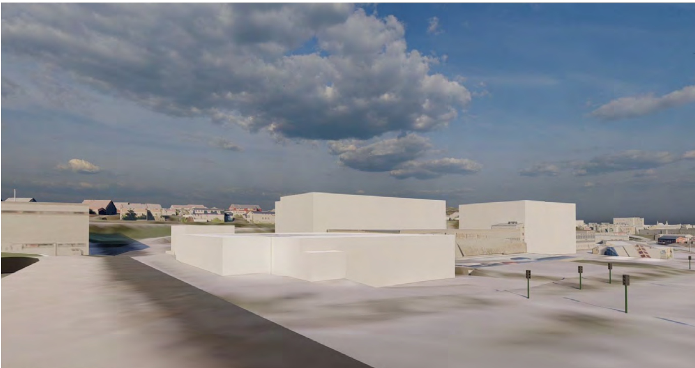
Nærvirkning eksisterende situasjon
