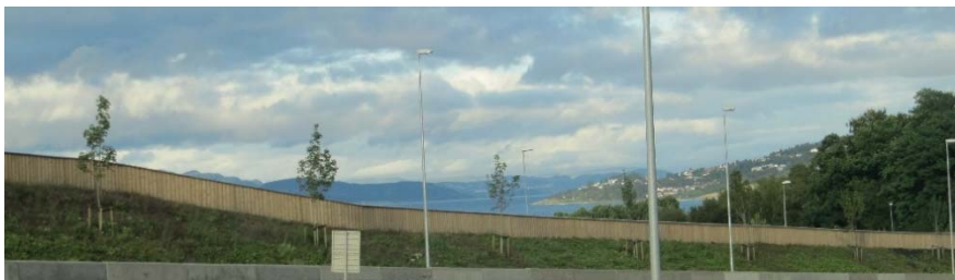
Foto over: Støyskjem med stående panel. Overkant skjerm følger terrenget uten «hakk».
