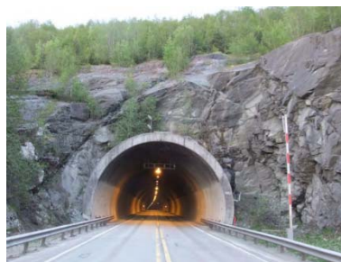
Foto: Portal Væretunnelen vest
