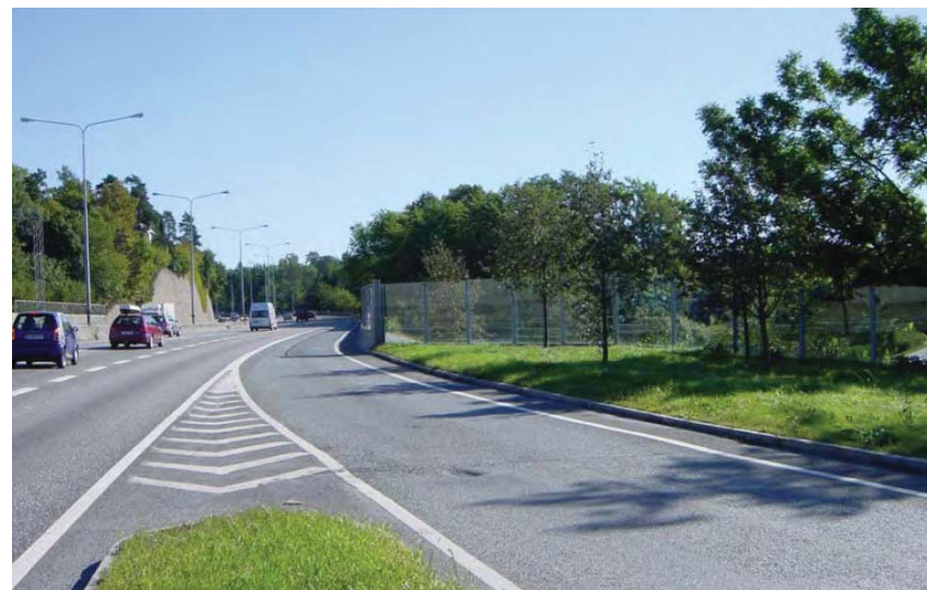
Kombinasjon voll/skjerm, og skjerm med og uten glass. Skjerm avsluttes mot terreng/vegetasjon. Skjerm har en dempet, mørk farge.
