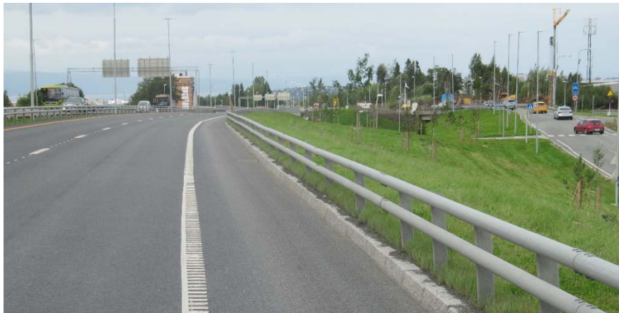
Vegrekkverk skal være åpent rørrekkverk, som gir et lett preg (bilde tatt ved City Syd, Trondheim)
