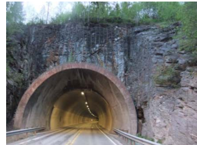
Foto: Væretunnelen, portal øst.
