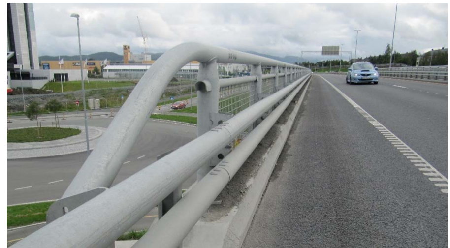
Brøytesikkert åpent rørrekkverk (bilde tatt ved City Syd, Trondheim)
