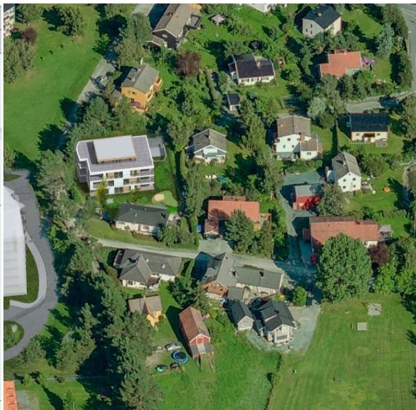
Figur 2: Flyfoto der den nye bygningen er plassert inn.
