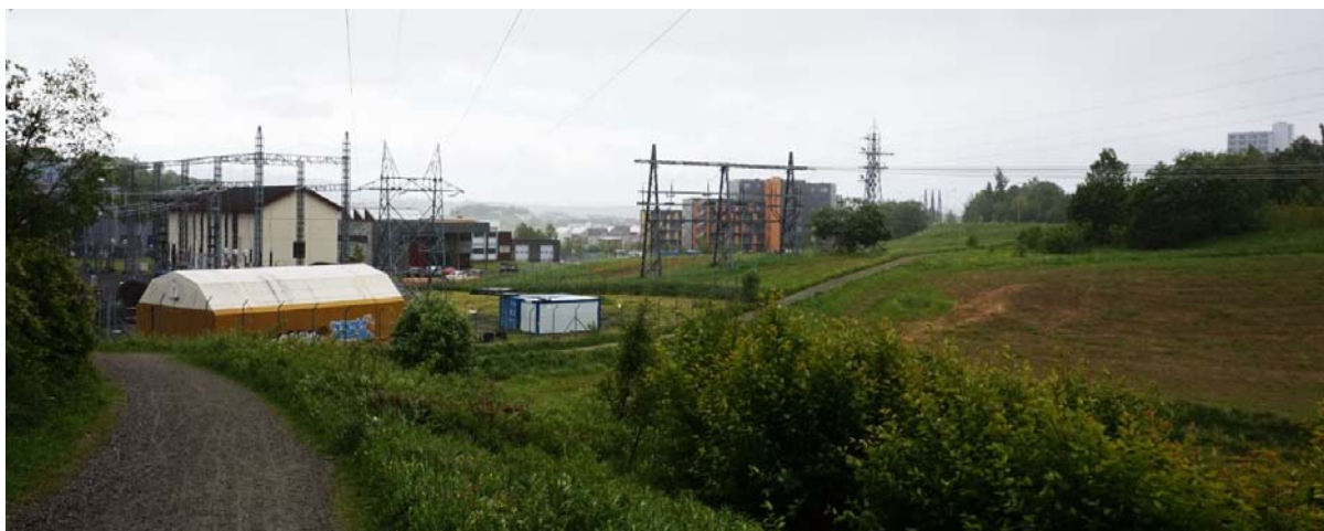
Figur 7-1: Foto over viser atkomsten til Strindamarka over tomta på Blakli. De store høyspentlinjene og Strinda trafostasjon reduserer opplevelseskvalitetene på tomta.
