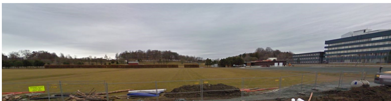
Dagens situasjon (kilde: Google)
