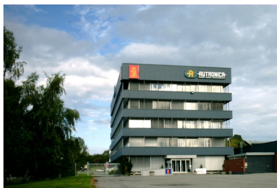
Autronicabygget (Kilde: http://brannsikring.as/wp-content/uploads/2013/03/Autronica.jpg )
